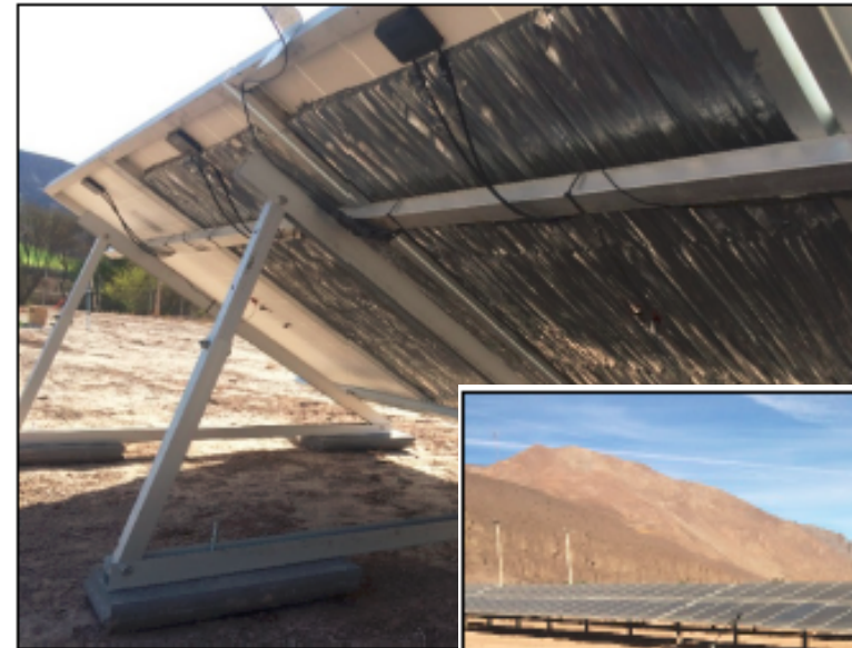
Imagen 11 – Imágenes de los disipadores en los módulos fotovoltaicos.
