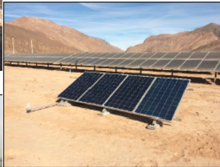
Imagen 10 – Estación de pruebas de 1[kWp] instalado en la planta fotovoltaica de Subsole en Copiapó.
