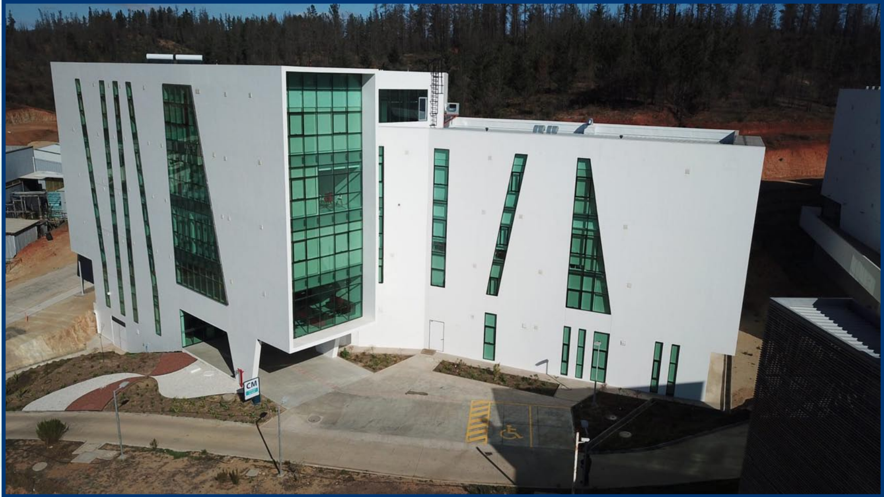
Edificio de la Escuela de Ciencias del Mar en Campus Curauma
