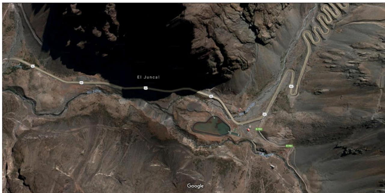
Represa Central Hornitos en el río Juncal.
